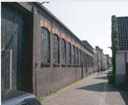
gesloten gemetselde gevelwand met grote raamopeningen aan de Hellingstraat
