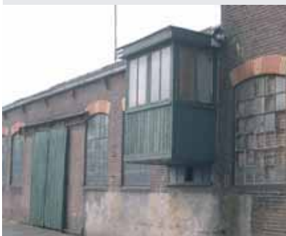
karakteristieke uitbouw (bazenhokje) als voorbeeld van toevoeging aan een industrieel gebouw
