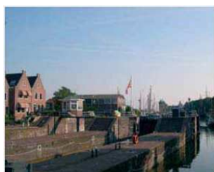
het plangebied gezien vanuit de sluisen
