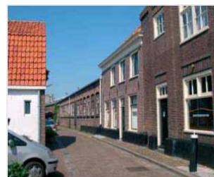
opbouw bestaande gevelwand van de voormalige scheepswerf aan de Hellingstraat.
